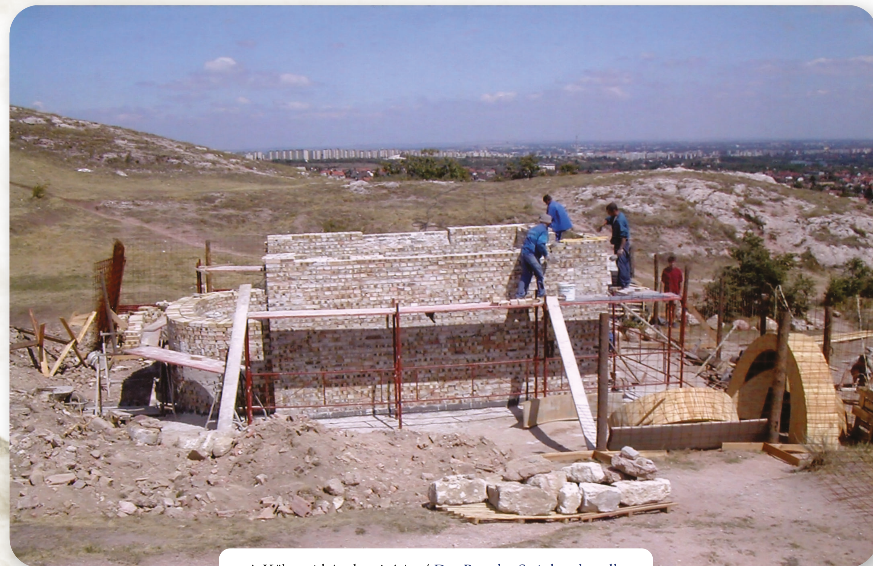
A Kőhegyi kápolna építése / Der Bau der Steinbergkapelle (Bleyer Jakob Helytörténeti Gyűjtemény / Jakob Bleyer Heimatmuseum)
